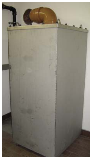
Biofiltry osazené v provozním prostoru
