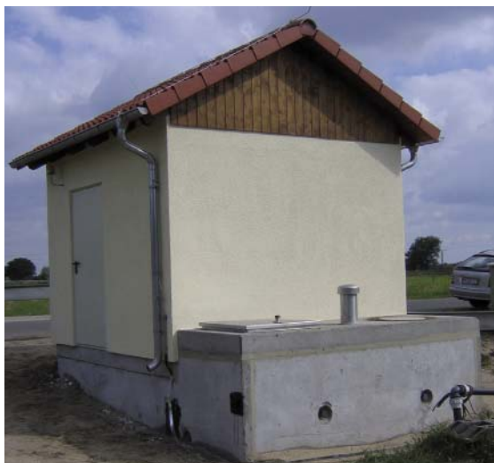
Integrované biofiltry v předšachtě
