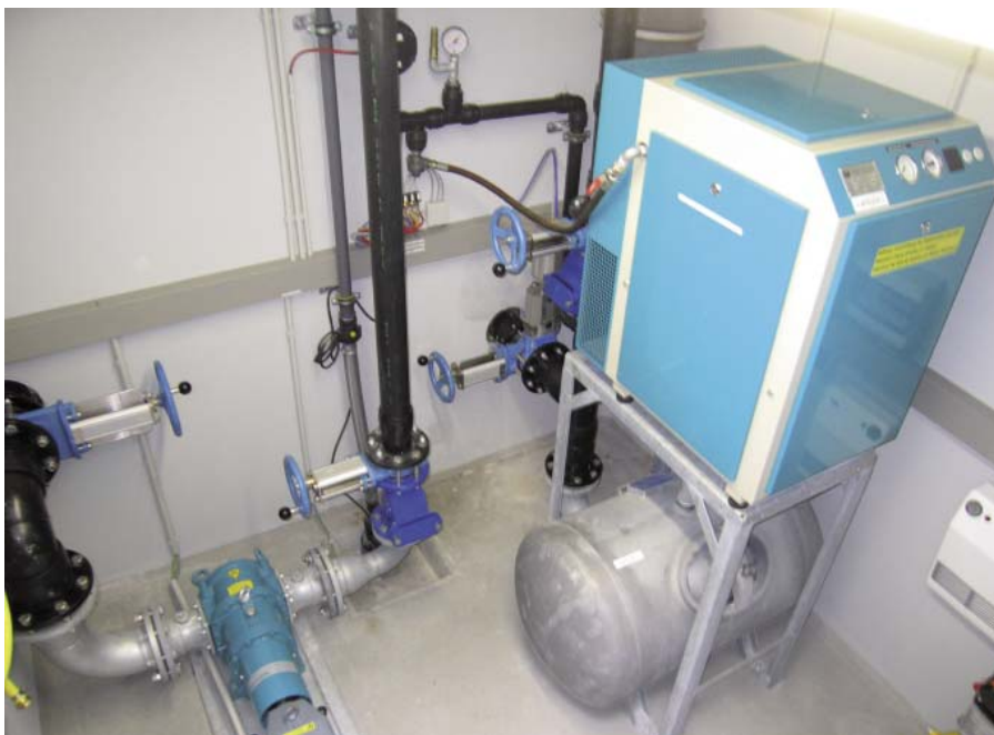
GULLICOMB® s rotačním pístovým čerpadlem
