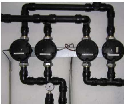
Membránové ventily pro přivádění provozního vzduchu
