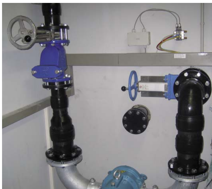
Dovybavení čerpadla ke zvýšení výkonu odvádění odpadních vod
