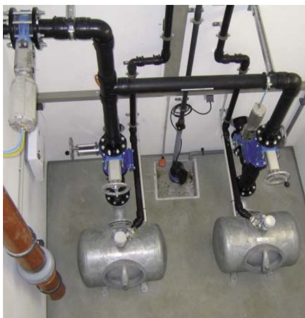
Vybavení pneumatické stanice
