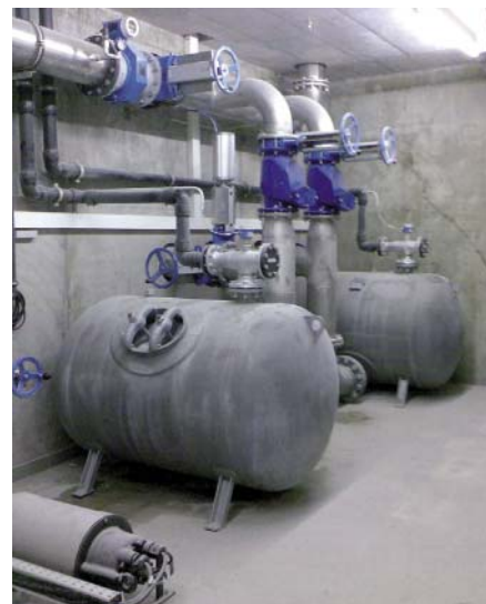
GULLICOMB® s jednokanálovým čerpadlem
