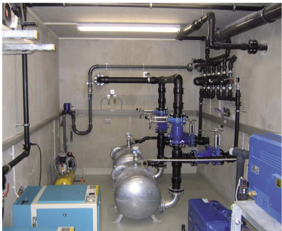
Provozní místnost čerpací stanice GULLIVAC ®
