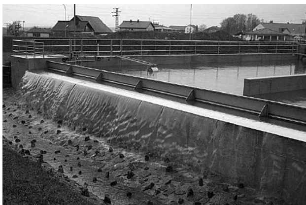
Obr. 3: Srážka na dešťové průtočné nádrži s velice malým pře- padovým paprskem. Přes přeliv teče pouze úzký paprsek vody, který je díky hladkému jezu stálý a rovnoměrný. Lze ho proto měřit po celé délce přelivu.
