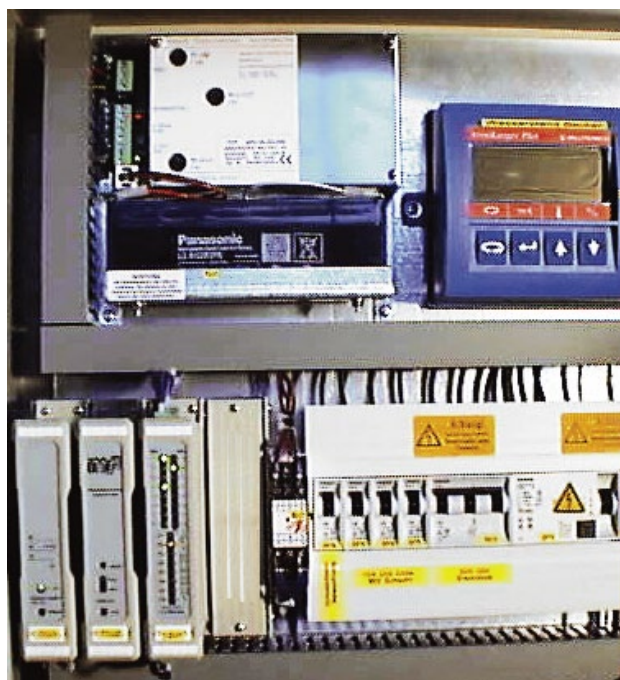
Obr. 1: Rozvaděč s dálkově ovládanou stanicí, FWL moduly, LPC, pojistky, el. přípojka je nutná
