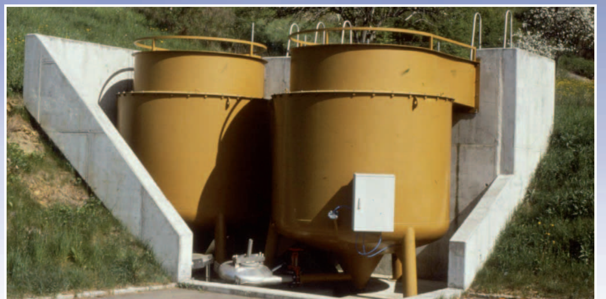
Obr. 5: Ocelová konstrukce separátorů v Tengen, Německo
