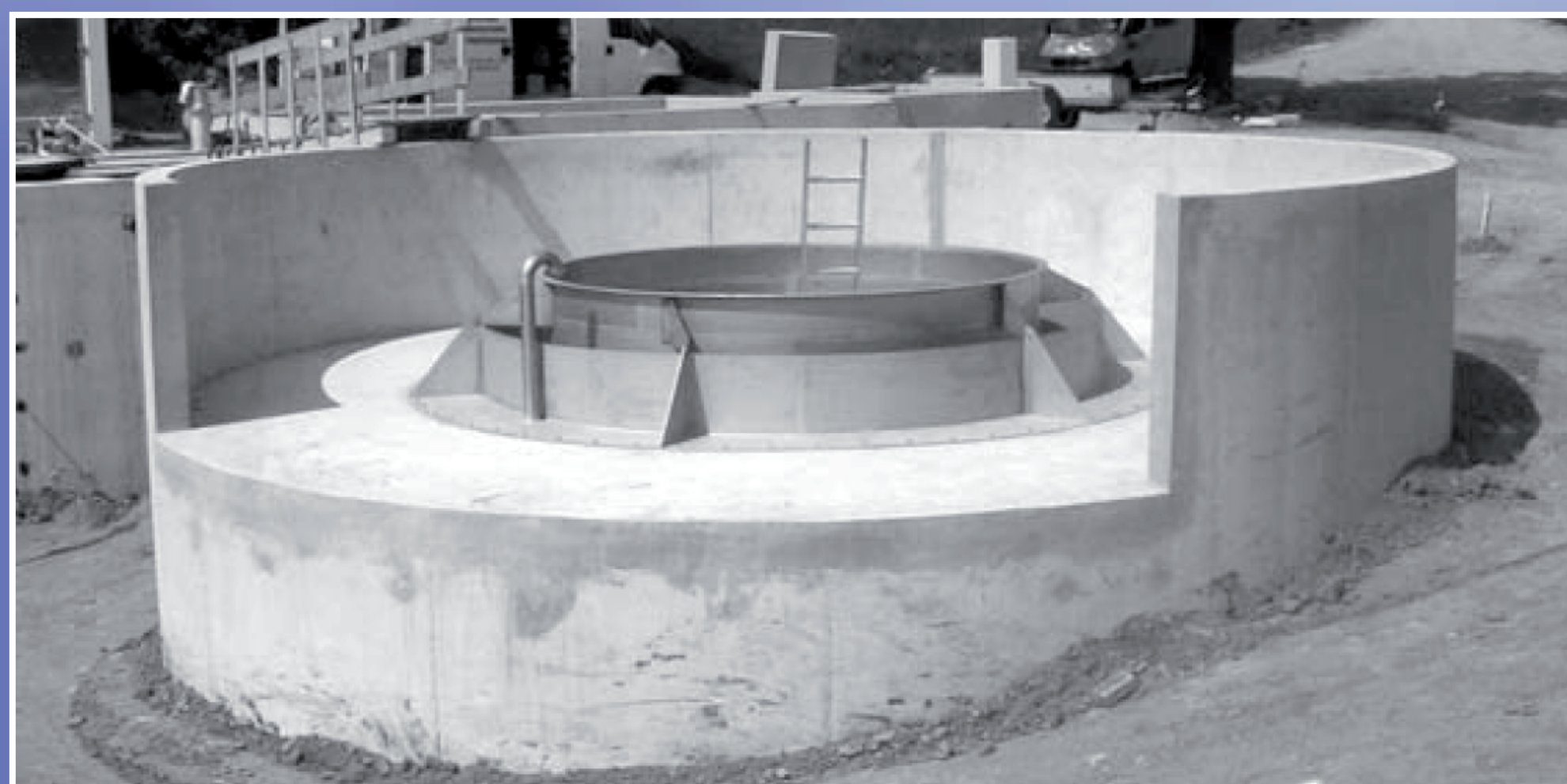
Na obr. 2 je znázorněna železobetonová konstrukce s ocelovou vestavbou. Tato kombinace materiálů se uplatňuje zejména u separátoru s větším hydraulickým zatížením.
