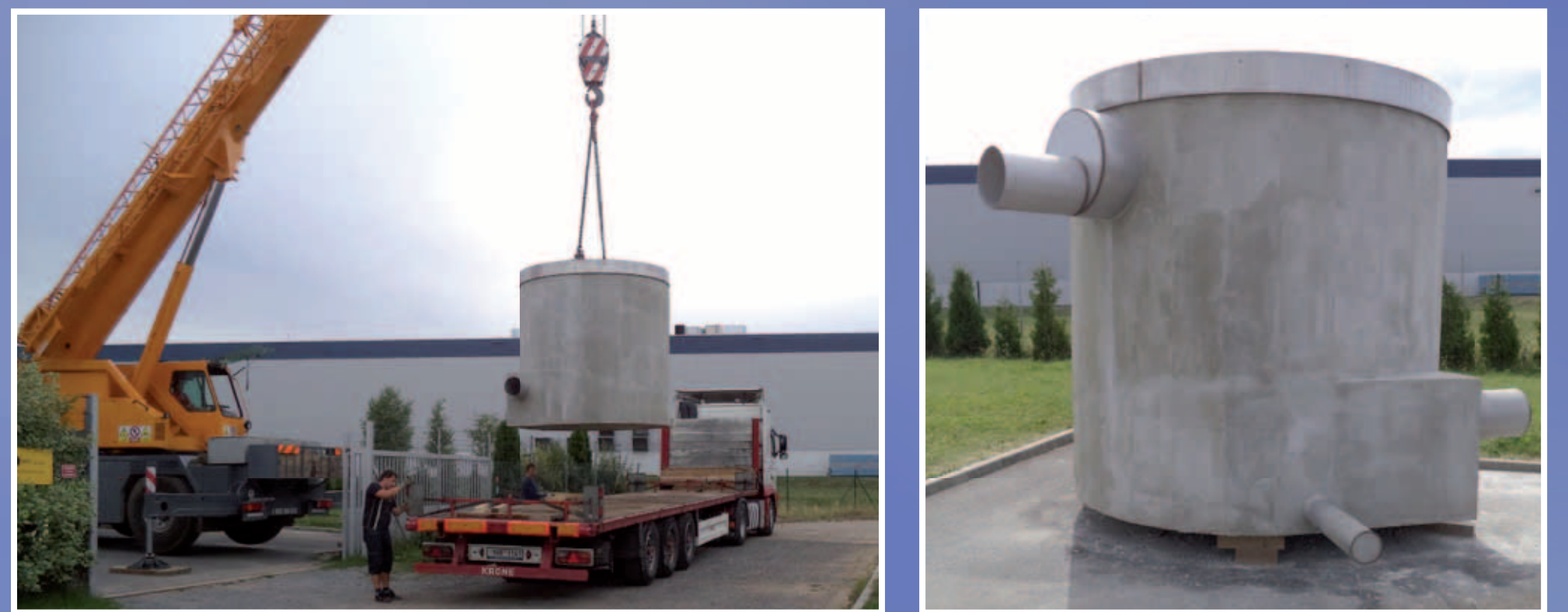
Obr. 3. a 4. prefabrikovaný vírový separátor Hoříčky
