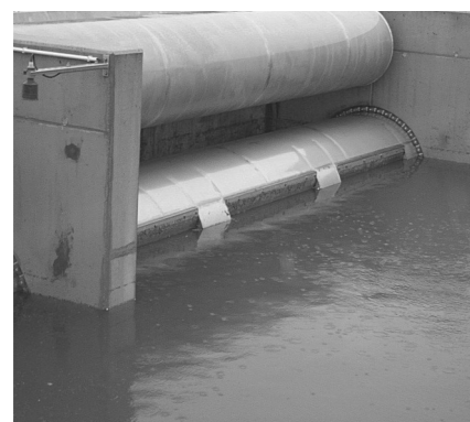
Obr. 5: Regulační čistící přeliv v trubním provedení, vlevo vnější pohled, vpravo pohled dovnitř trubky
