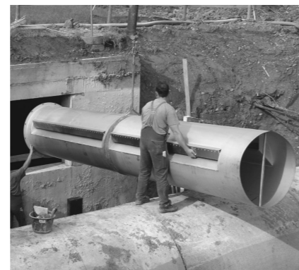
Obr. 6: Osazení čistícího přelivu do stávajícího objektu
