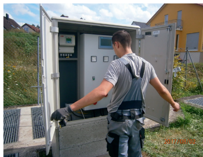
Bild: Endkontrolle am neuen Schaltschrank nach der Montage
